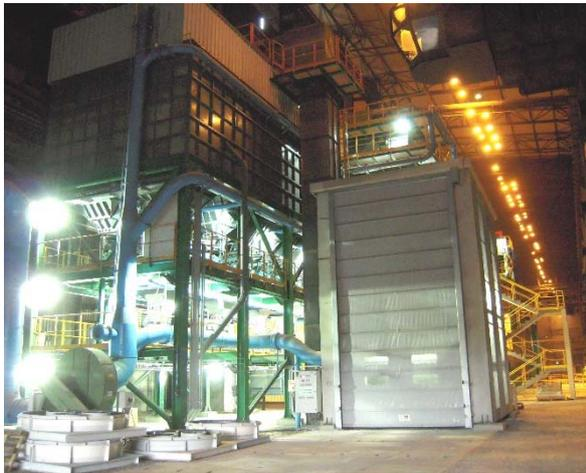
Sistema di raccolta polveri con ventilatori, filtri e relativo sistema di immagazzinaggio delle polveri.
